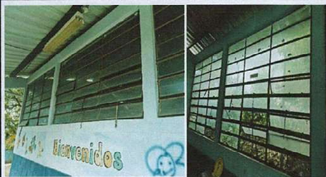
Foto 1: Sustitución de ventanas tipo PVC de 1.71mts de alto por 2.31 de ancho.
