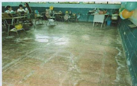
Foto 2: Reparación de piso de acabado liso, por piso cerámico.
