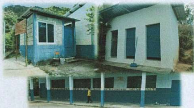
Foto 5: Colocación de pintura en aulas, cocina y baños.
