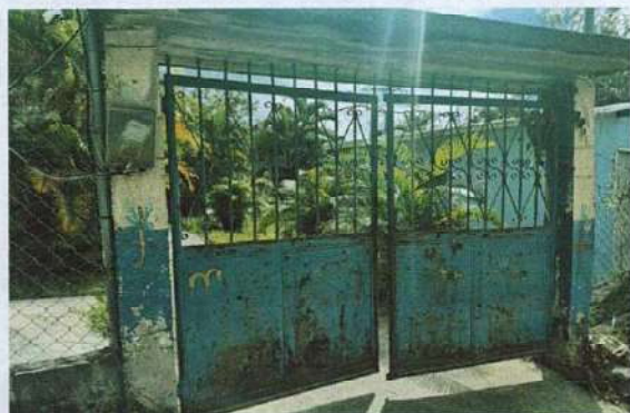
Foto 3: Mantenimiento de porton principal (lijado, soporte y pintura)
