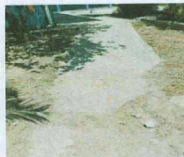
Foto 4: Reparación de losa de concreto en ingreso al establecimiento
